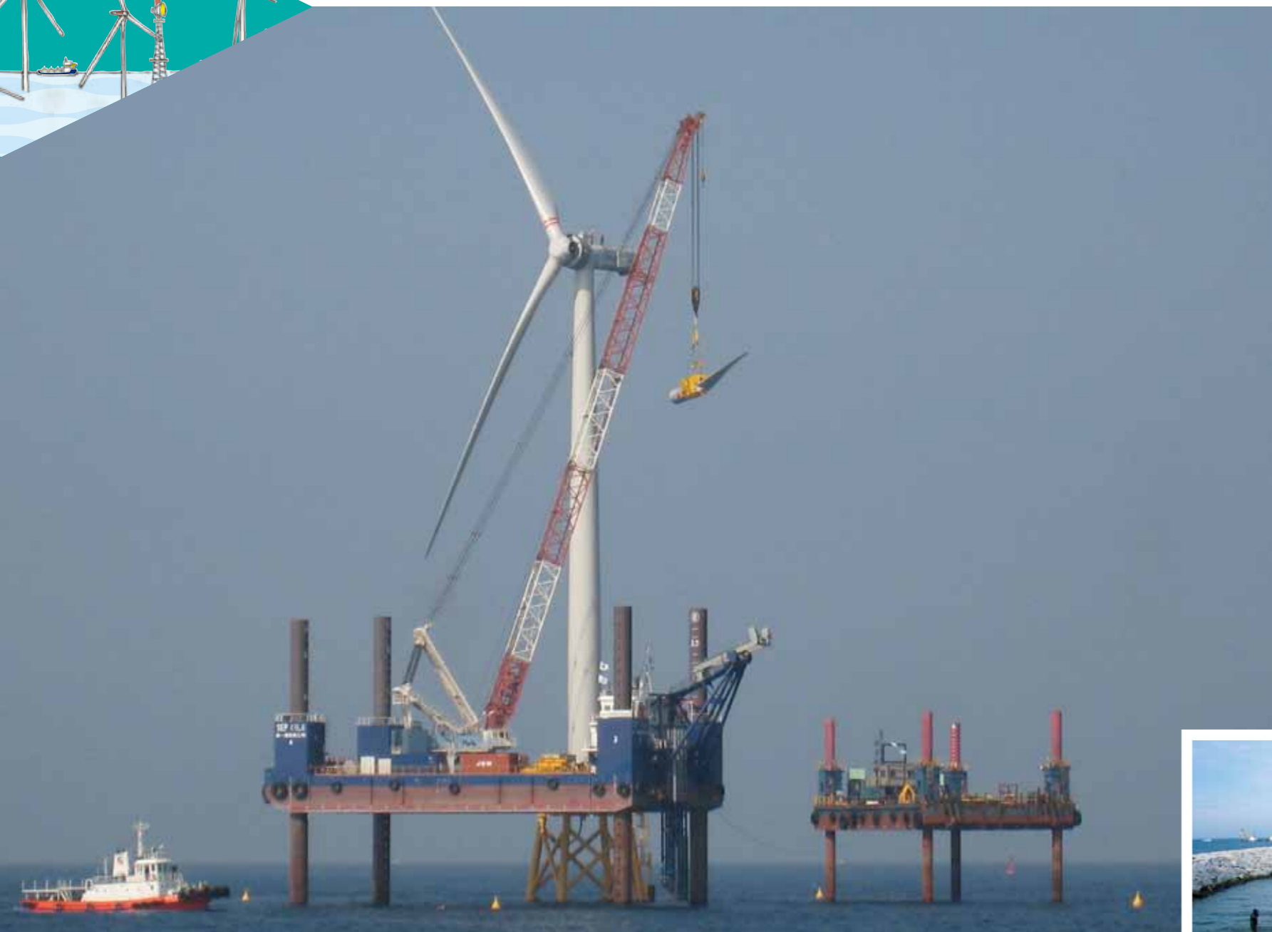
北九州市沖での洋上風車パーツ設置の様子
