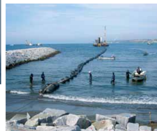
銚子沖での海底ケーブル敷設の様子
