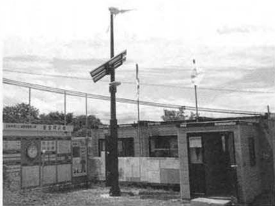
1台で仮設事務所の照明とPC10台程度賄える
