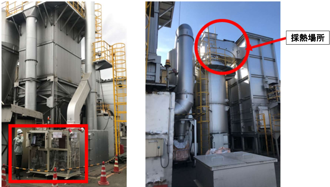
図2 鈴木工業(株)のエコミュージアム21に設置したORC発電システム(写真左)と採熱場所(写真右)
