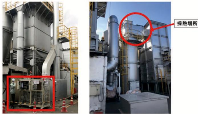
鈴木工業園エコミュージアム21に設置したORC発電システム（写真左）と採熱場所（写真右）
