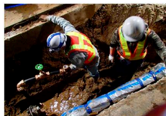
仙台市水道本管工事
