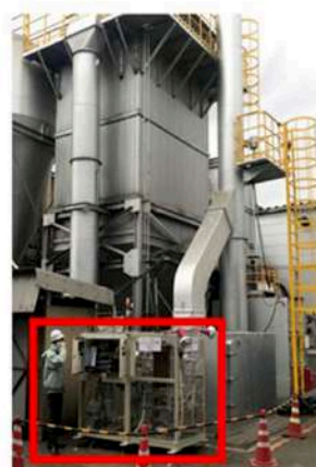
鈴木工業㈱エコミュージアム21に設置したORC発電システム（写真左）と採熱場所（写真右）
