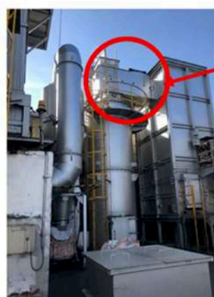
鈴木工業㈱エコミュージアム21に設置したORC発電システム（写真左）と採熱場所（写真右）
